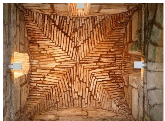
Interior bóveda de aresta
